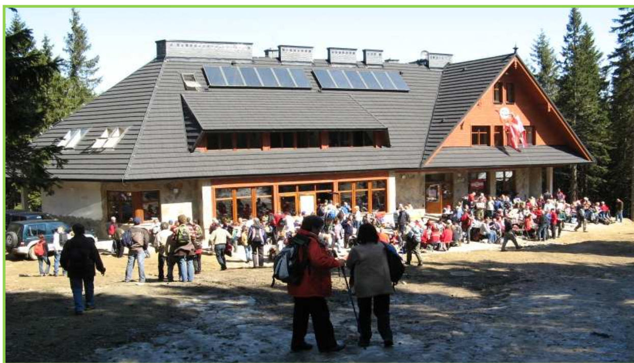
Nowy budynek schroniska PTTK na Markowych Szczawinach. 25 kwietnia br.
