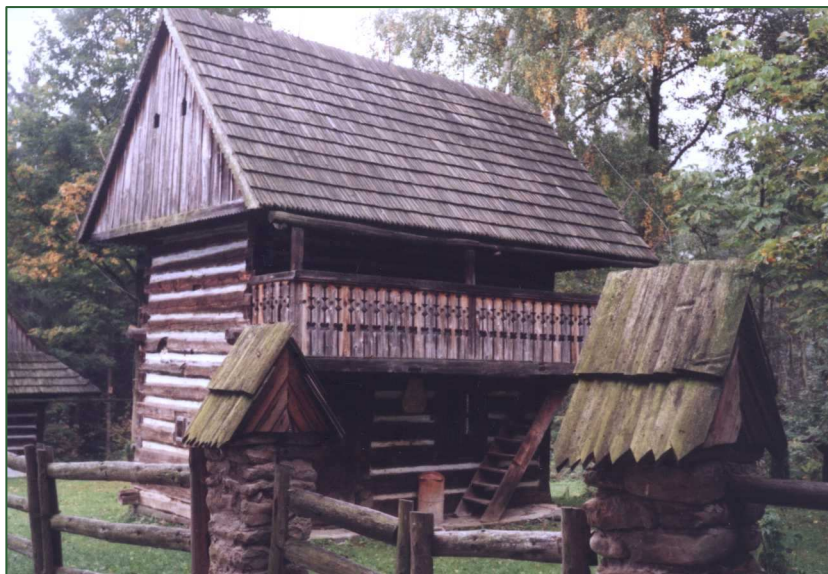
Sidzina Binkówka. Mini skansen budownictwa drewnianego
